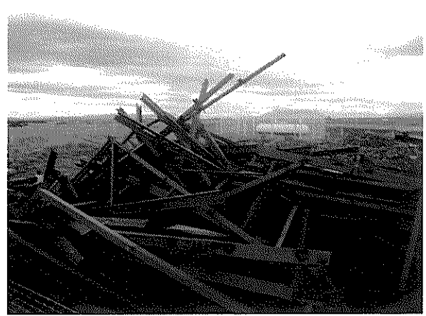
Fotografía N° 5. Acopio de estructuras metálicas
