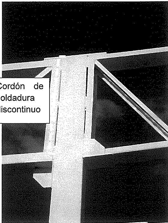
Fotografía N° 2. Soldadura discontinua en las uniones de pilares y vigas metálicas.
