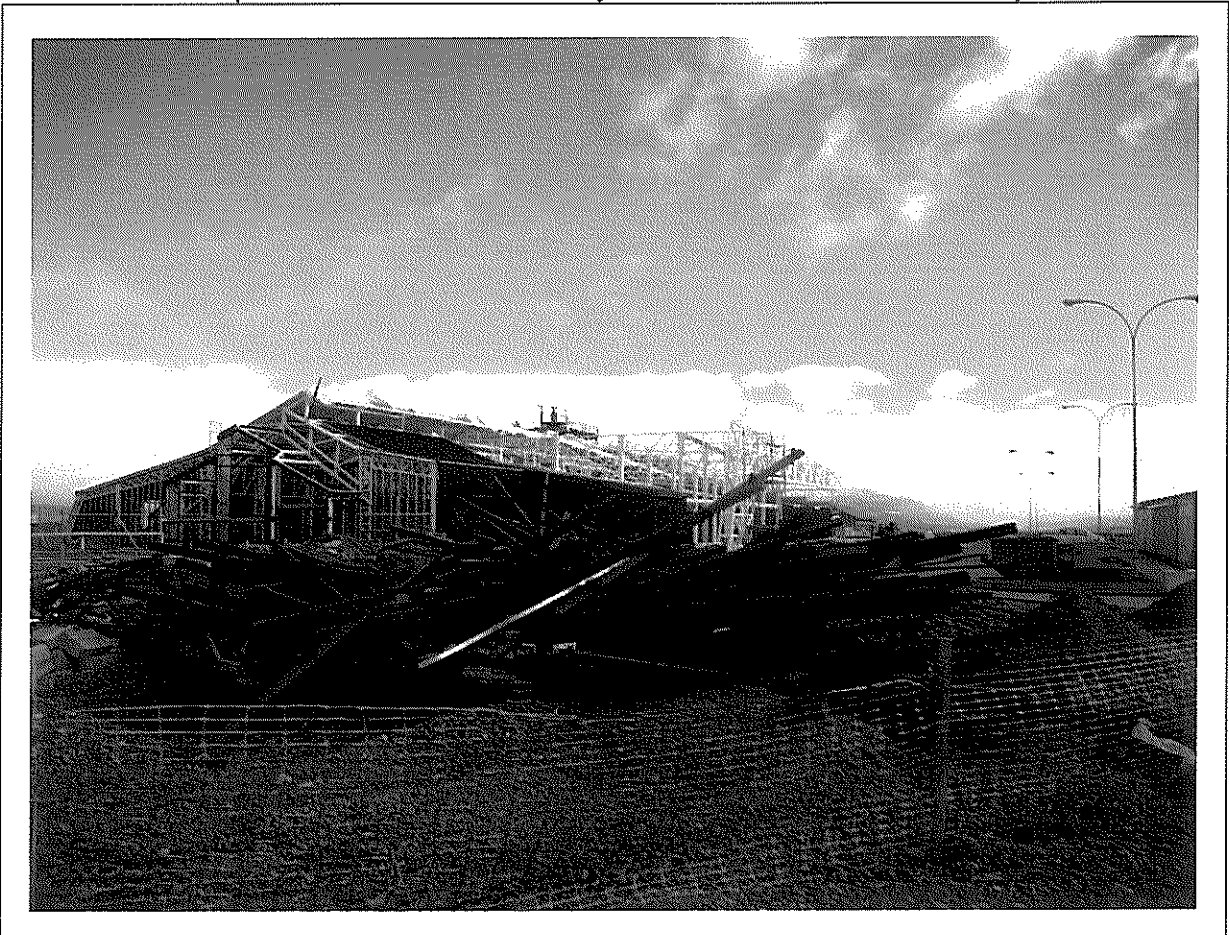
Fotografía N° 1. Situación General de acopio de escombros en obra.
