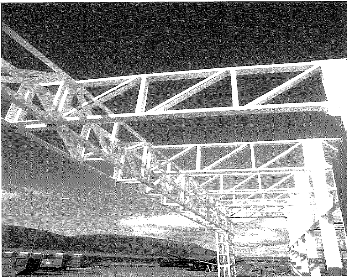
Fotografía N° 3. Situación eje "J".
